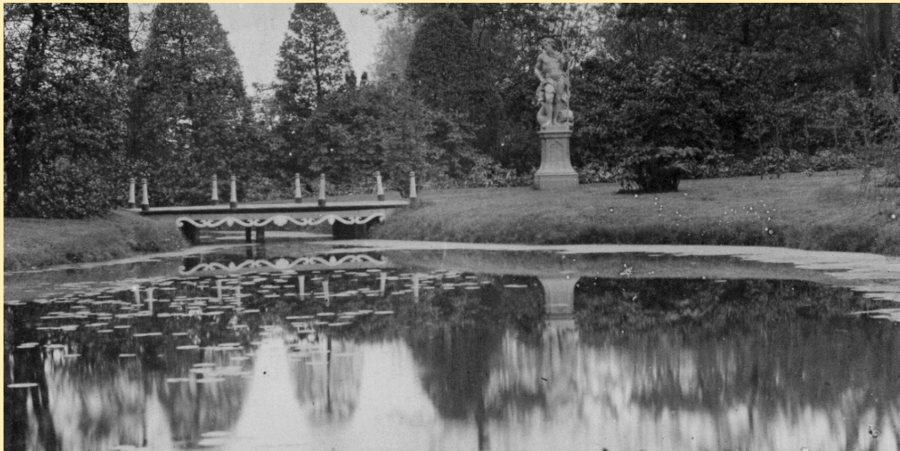
Brug over de vijver (collectie SBvV)
